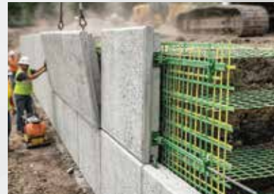
PRECAST MSE WALL
